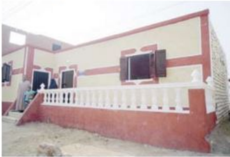
أحد المنازل التي تم بناؤها
