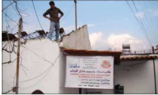
جانب من ترميم بيوت فقراء
