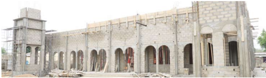
مسجد قيد البناء
