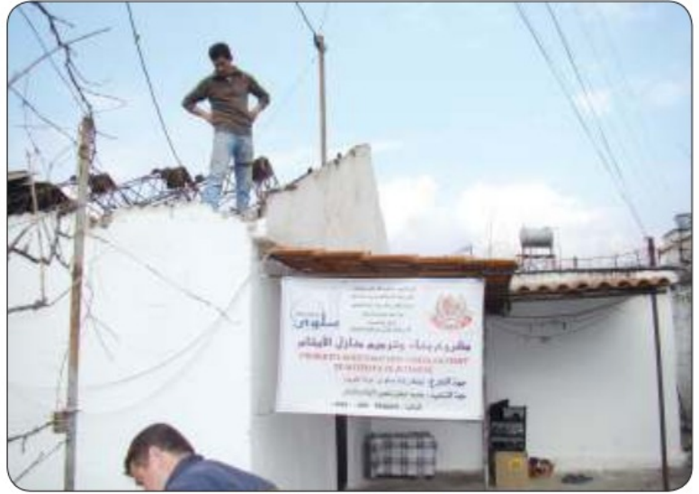
ترميم بيوت فقراء
