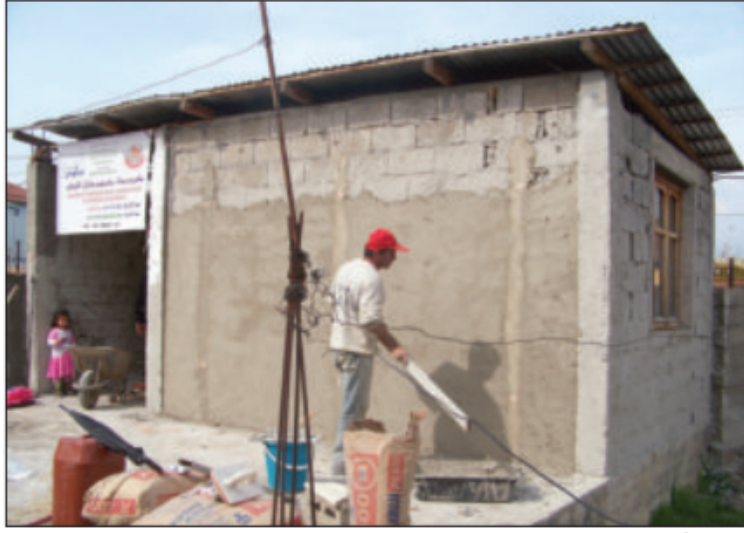
جانب من أعمال الترميم
