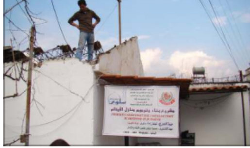
جانب من ترميم بيوت فقراء
