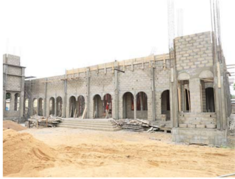
مسجد تحت البناء
