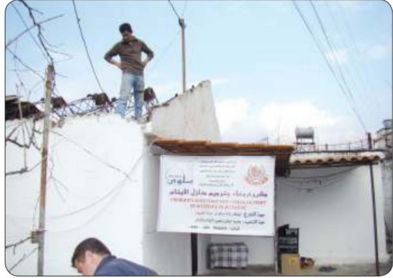
■ ترميم بيوت فقراء
